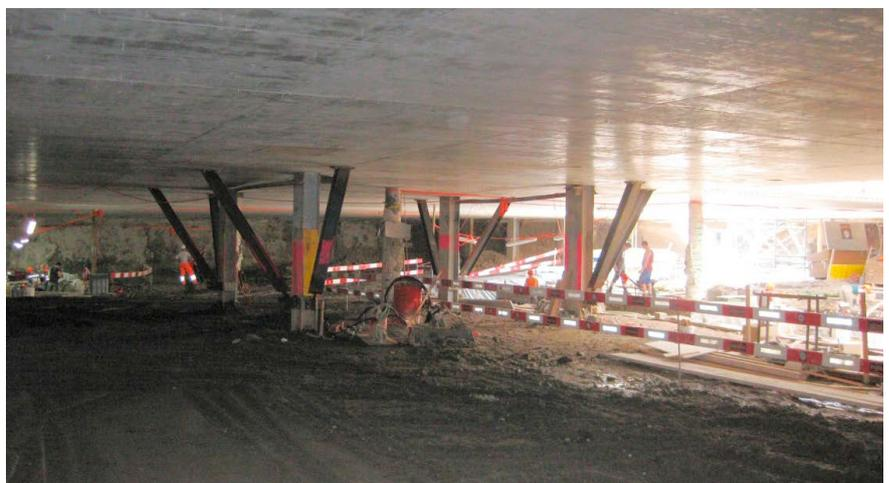
ABBILDUNG 14: AUSHUB IN DECKELBAUWEISE MIT PROVISORISCHEN STÜTZEN IN EINEM VERGLEICHBAREM OBJEKT (PARKHAUS OPÉRA, ZÜRICH)
